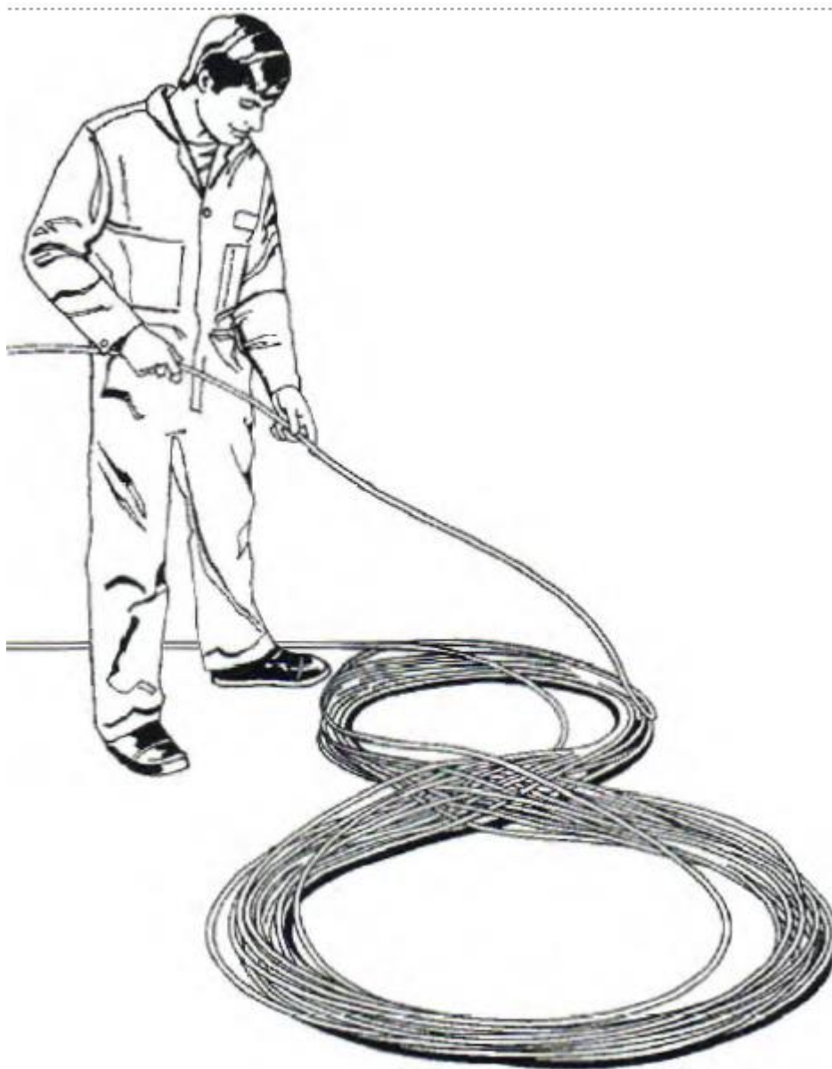
Рис. 20 Укладка кабеля
